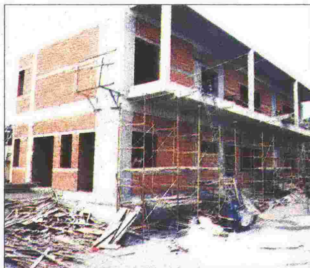
Με ταχείς ρυθμούς προχωρούν οι εργασίες για την ανέγερση της μονάδας φροντίδας ηλικιωμένων
